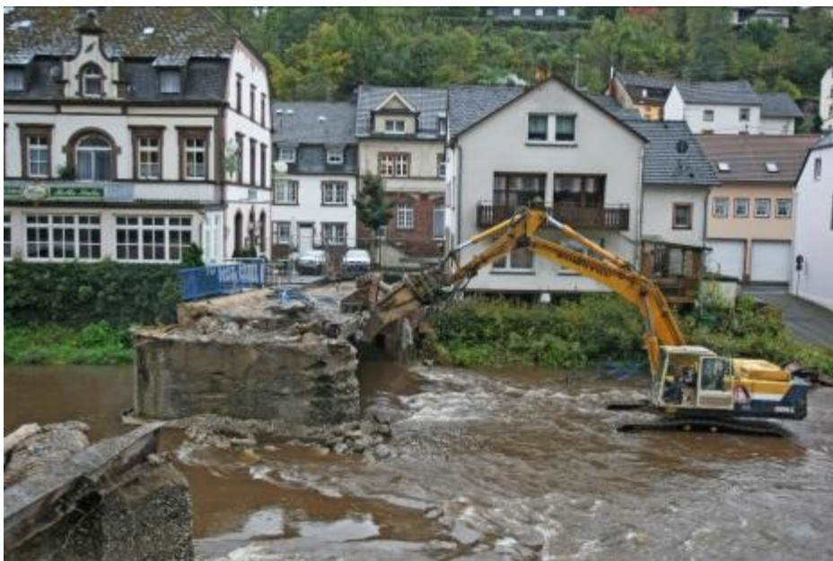
ABRISS: Die alte Kyllbrücke muss weichen. Die Pfeiler bleiben stehen und werden saniert. Darauf wird bis Ende 2008 eine neue Stahlkonstruktion verlegt. TV-Foto: Rudolf Höser
